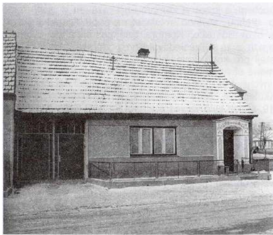
Tvrdonice, dům č.p. 111 se žúdrem po stavební úpravě.
