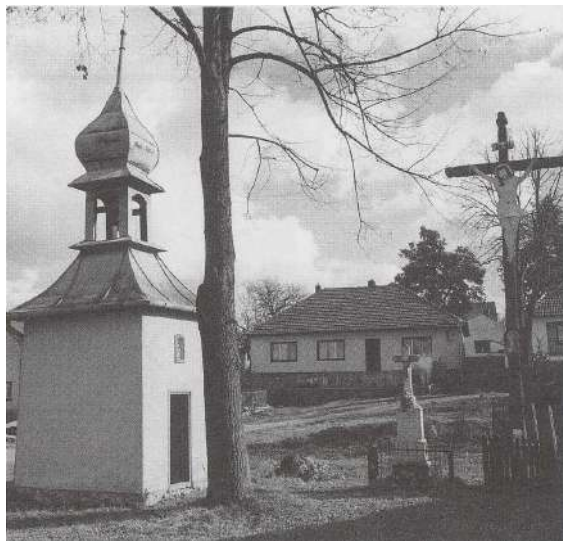
Nová Ves, zvonice před obnovou
