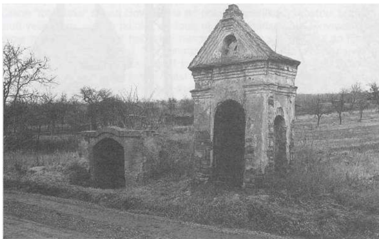
Havraníky, poklona v havarijním stavu
