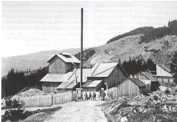
Budova strojovny, nedatováno.
