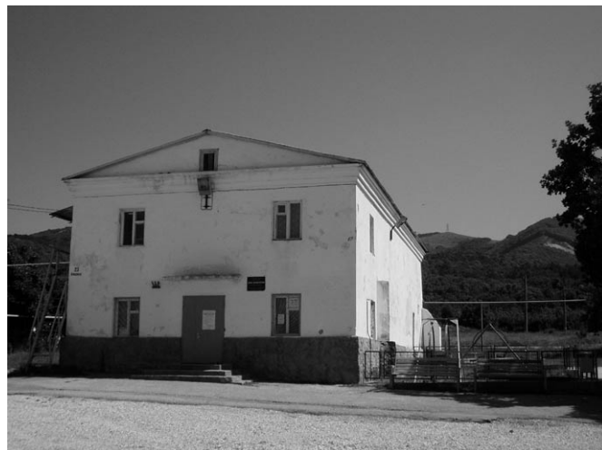
Budova bývalého kostela v Kirillovce dnes slouží jako objekt k obecním potřebám.
