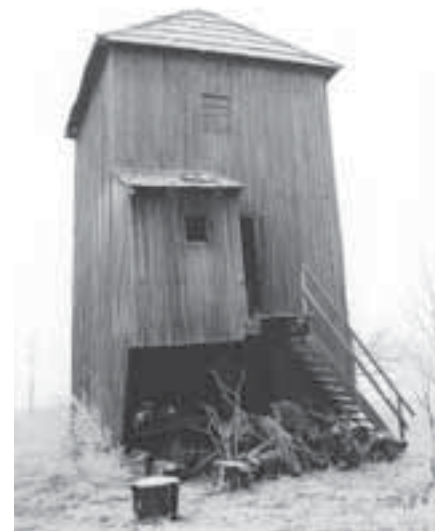
Starý větrný mlýn ve Starém Poddvorově před opravou. Foto V. Kovářů 1996.
