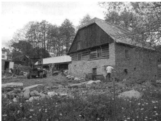
Stavba vodního mlýna z Radešic. Muzeum vesnických staveb středního Povltaví Vysoký Chlumec. Foto D. Drápala 2010.
