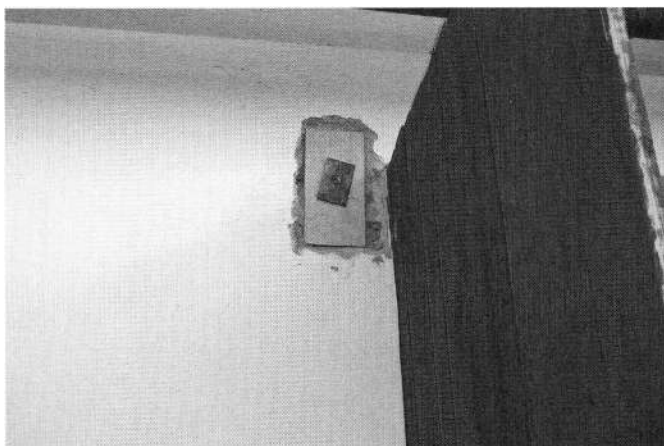
Obr. 4. Rozšíření styčné plochy mezi kotevní ocelovou deskou a hliněnou stěnou podložkou z dubové fošny. Foto I. Žabičková 2008.
