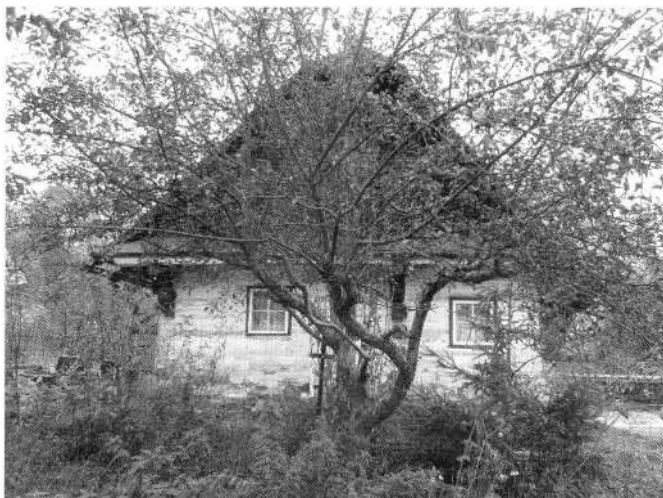
Obytný dům čp. 68, pohled severní. Žilina u Nového Jičína. Foto M. Baďuříková 2009.
