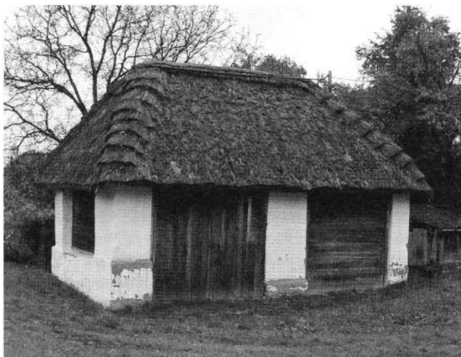
Pilířová stodola jedenáct let po omítnutí hliněnou omítkou (Ježkovice u čp. 27). Foto A. Dunajová 2009.
