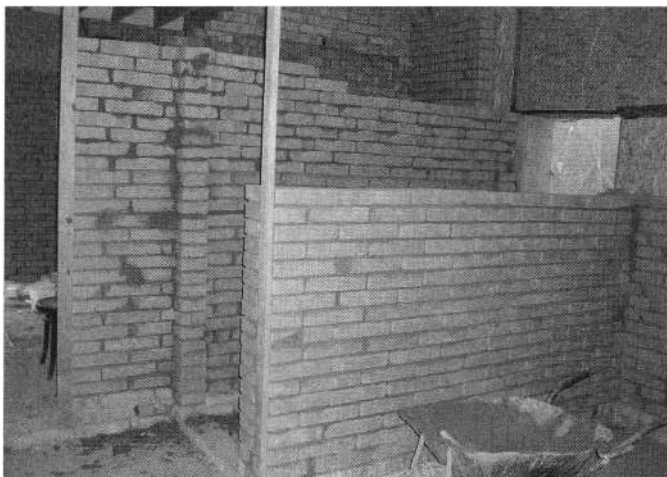
Obr. 6. Hliněné příčky a obezdívky v dřevostavbě. Foto I. Žabičková 2005.
