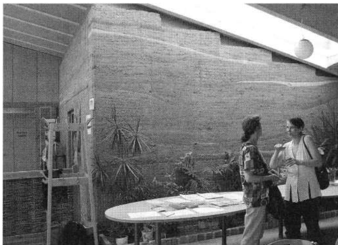
Obr. 9. Stěna z dusané hlíny s barevnými jíly. Foto I. Žabičková 2005.
