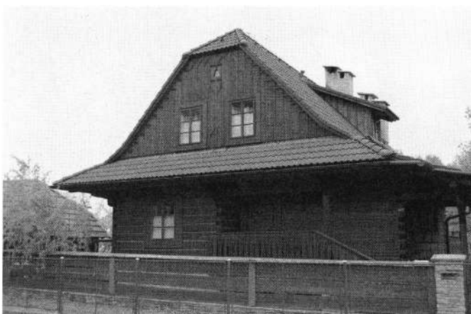
Obytný roubený dům čp. 432, pohled jižní. Rožnov pod Radhoštěm. Novostavba z roku 2000 dle návrhu A. Závady. Foto A. Závada 2010.
