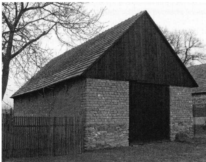
Stodola po opravě pomocí hliněné technologie. (Hrubá Vrbka u čp. 82). Foto A. Dunajová 2009.
