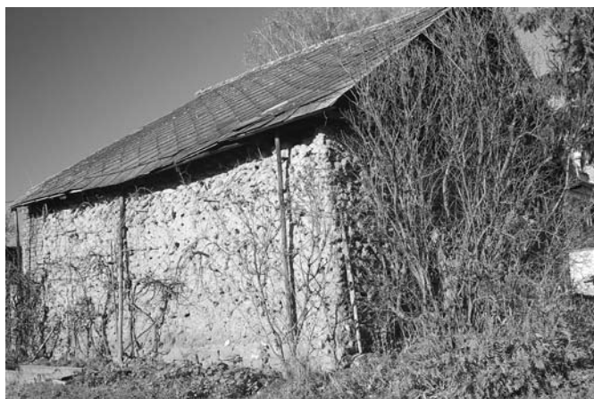
Hruška – zbytek stodoly (k čp. 71) z klasovitě kladených válků. Foto M. Novotný 2009.
