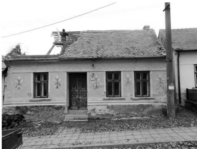
Obr. 6 – Petrovice, demolice usedlosti čp. 23 s šablonovou výzdobou fasády. Foto Obecní úřad Petrovice 2012.
