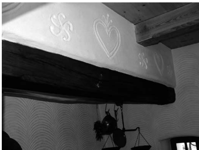
Obr. 4 – Kučerov, usedlost čp. 12, nově provedený prstový vtačovaný dekor v černé kuchyni. Foto A. Dunajová 2014.
