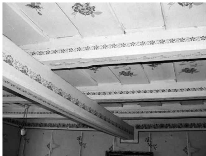
Obr. 3 – Lysovice, usedlost čp. 72, strop světnice vyzdobený pomocí šablon. Obě foto A. Dunajová 2014.
