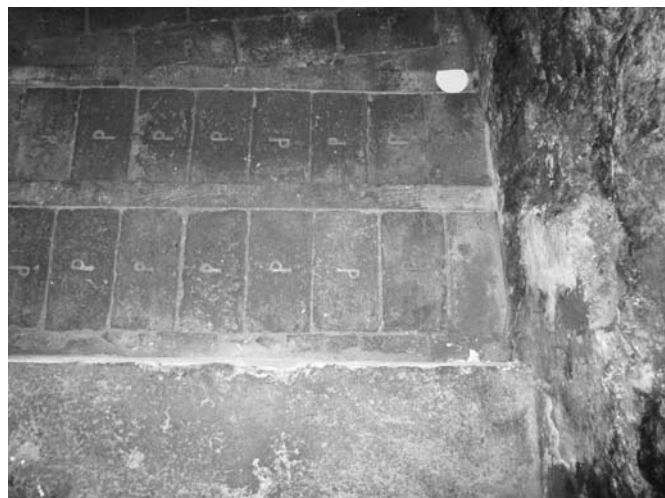
Obr. 12 – Pavlov, podlaha vinného sklepa v ulici Česká, dlážděná kolkovanými cihlami z obecní cihelny. Foto A. Dunajová 2014.
