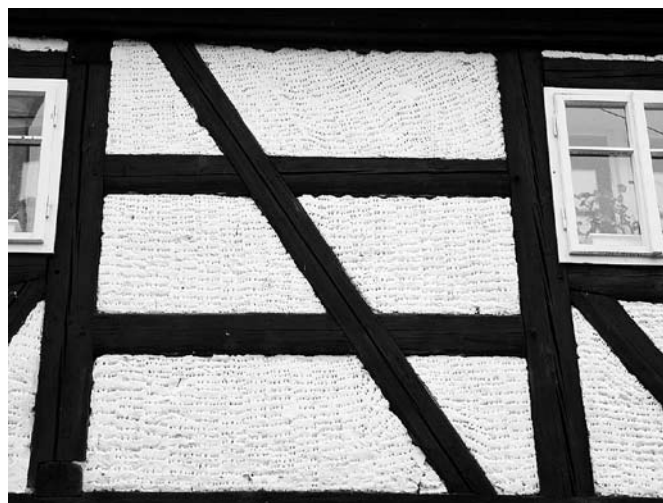
Obr. 5b – Valeč, usedlost čp. 15, detail plastické výzdoby brázděných výplní „Murl“. Foto A. Dunajová 2015.
