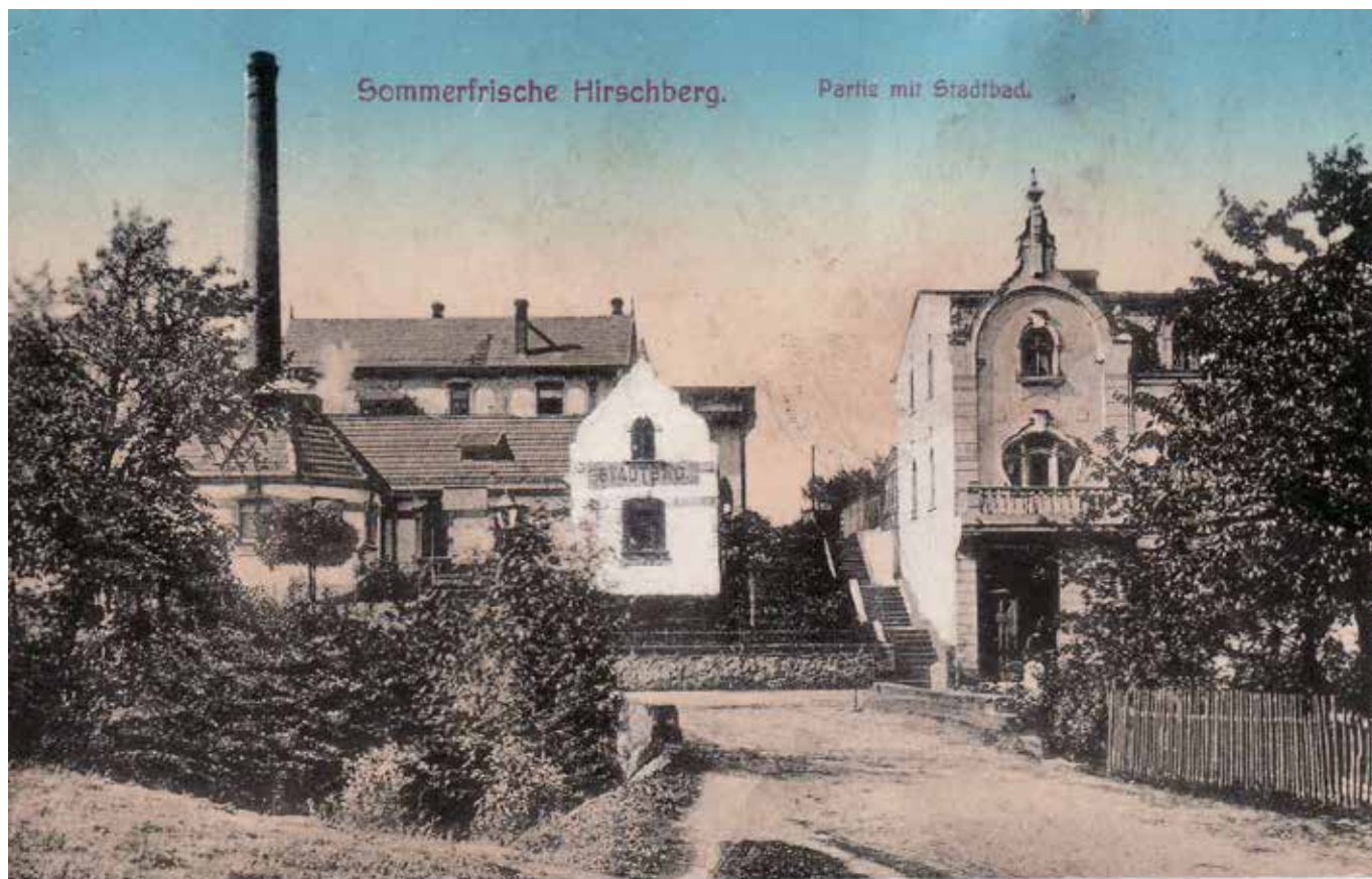
Obr. 6. Budova městských lázní s nápisem „Stadtbad“. V pozadí stojí mlékárna, jež lázním poskytovala vodu i páru. Archiv Renaty Mauserové, Sommerfrische Hirschberg (Partie mit Stadtbad) (pohlednice)
