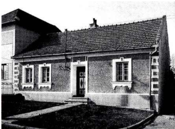
Lysovice, stavení č.p. 80
