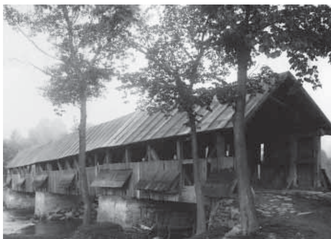
Krytý most přes Svratku v Unčíně. Foto B. Vavroušek 1922.
