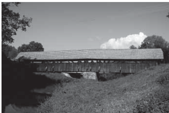
Dřevěný krytý most v Černvíře. Celkový pohled. Foto autor 2004.
