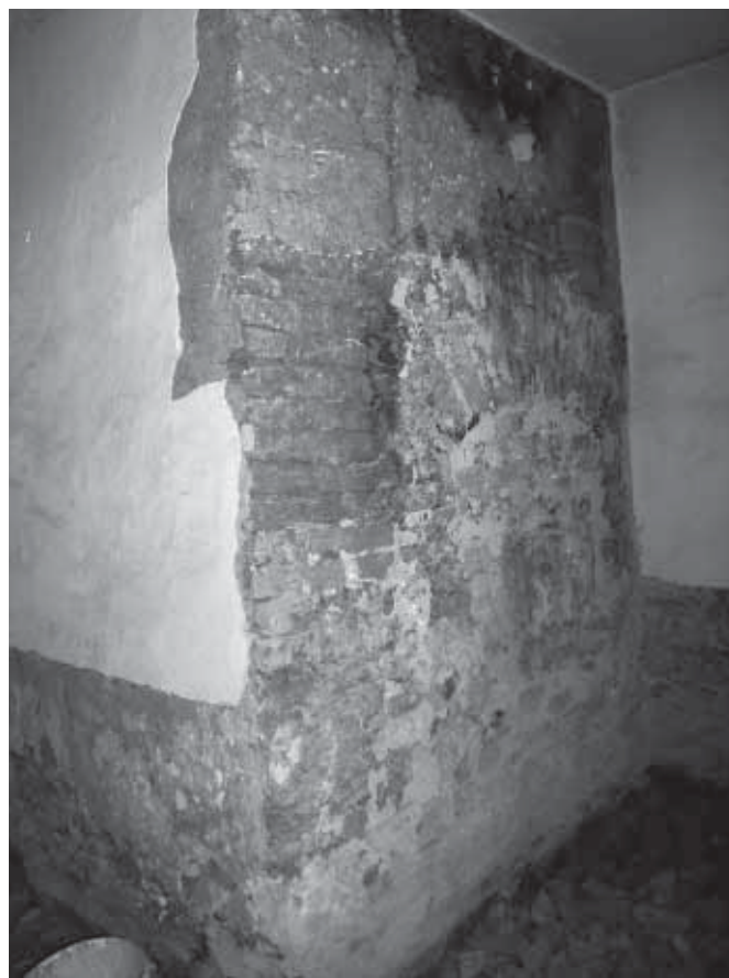
Komora. Zazděné prostupy do zrušené pece. Foto M. Hanzlíková 2005.
