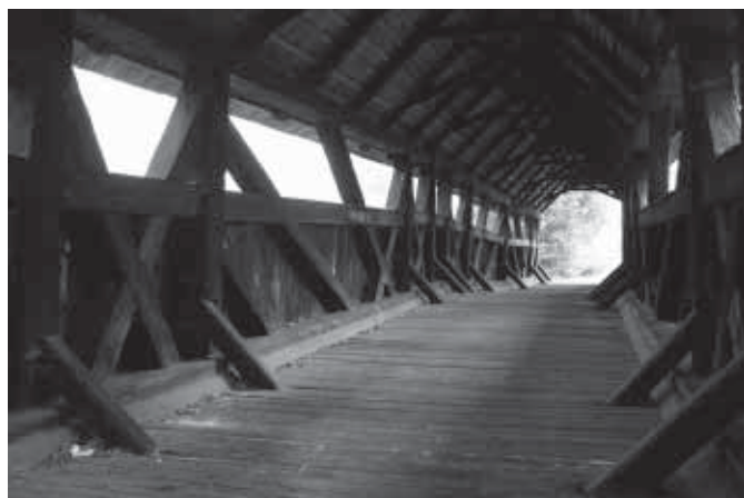
Pohled na trémovou konstrukci černvířského mostu. Foto autor 2004.
