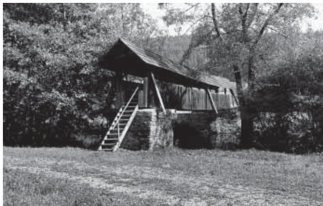
Dřevěná krytá lávka ve Švaří. Pohled z pravého břehu řeky Svatky. Foto autor 2004.
