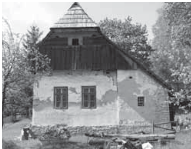
Obytná část bývalé zemědělské usedlosti na Hřebečsku datovaná do 16. a 17. století (jízba po r. 1545/1583, komorová část 1632/1693). Čísťa u Litomyšle čp. 171. Foto M. Válka 2005.
