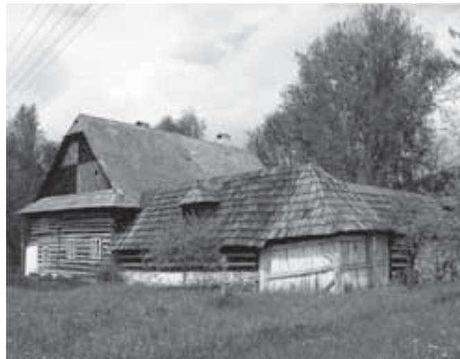
Bývalá selská usedlost tzv. poličského typu s uzavřenou čtyřbokou zástavbou dvora. Typ usedlostí z 18. století (datace ve vrcholu lomenice 1787 ?). Telců čp. 16. Foto M. Válka 2007.
