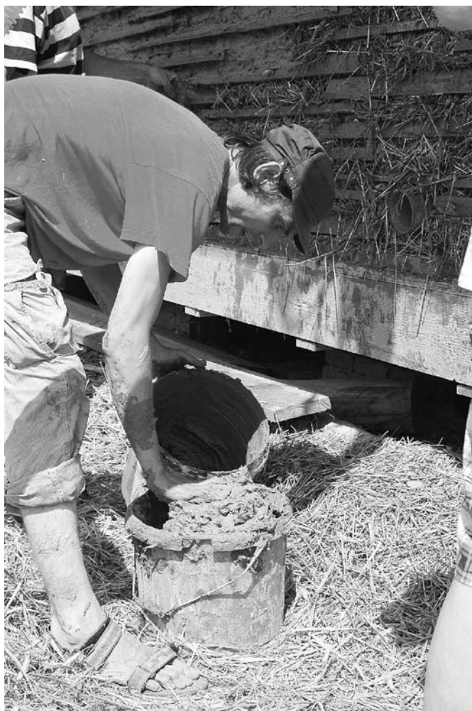
Obr. 10. Omítání domu postaveného z balíků slámy hliněnou omítkou. Brdo u Luže (okr. Chrudim). Foto A. Jasanská Melkusová 2013.
