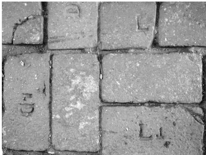
Obr. 8. Pálená cihla se značkou „L“ z panské cihelny v Lysicích. Doklad lokální výroby cihel v 19. století před její koncentrací do velkých podniků. Foto M. Válka 2013.
