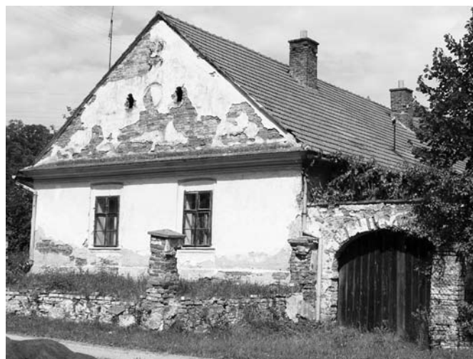
Obr. 5. Selský statek postavený z pálených cihel s datací 1858 ve štítě. Doklad pozdně klasicistní formy zděných staveb, které vznikaly přestavbou starších roubených usedlostí na západní Moravě. Střemchoví (okr. Brno-venkov). Foto M. Válka 2005.
