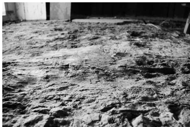
Obr. 3. Dobřčice čp. 5 – detail vrstveného zdiva bývalé komory – pohled z lochu. Foto M. Novotný 2011.
