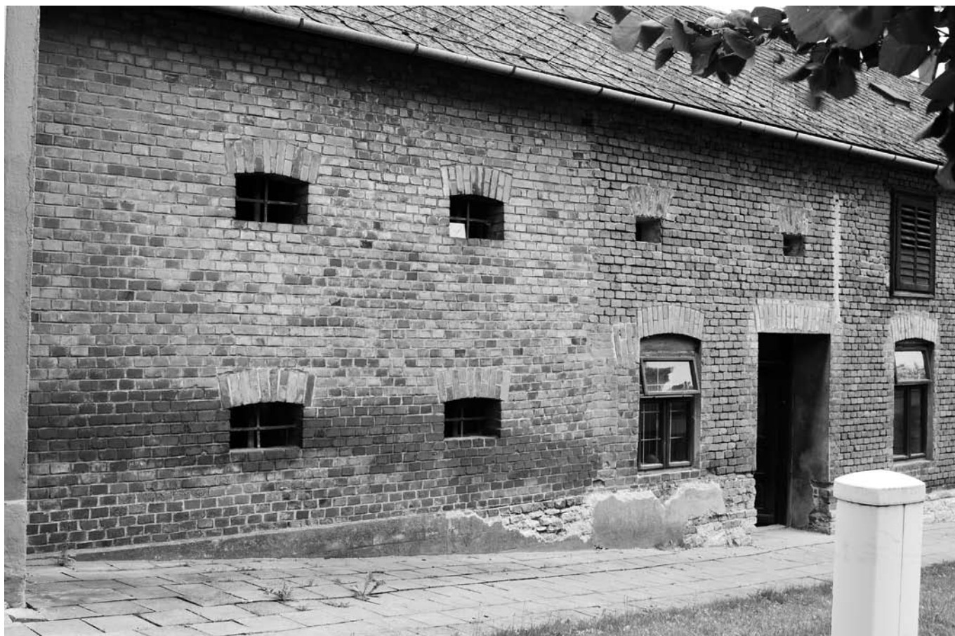
Obr. 1. Dobřčice čp. 5 – pohled na komorovou část domu. Foto M. Novotný 2011.
