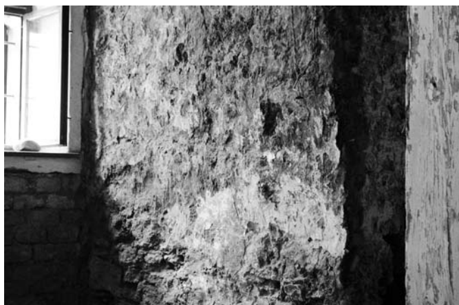
Obr. 2. Dobřčice čp. 5 – detail vrstveného zdiva bývalé komory. Foto M. Novotný 2011.
