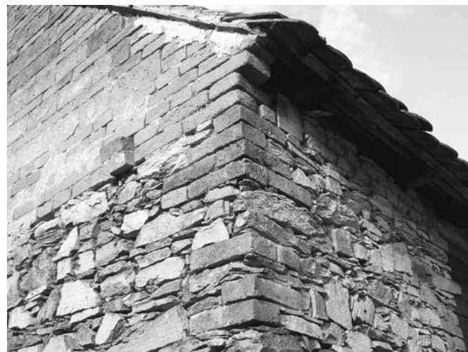
Obr. 7. Účelová kombinace různého stavebního materiálu (kámen, pálená a nepálená cihla) ve stěně selské stodoly z konce 19. století. Rapotice (okr. Třebíč). Foto M. Válka 2013.
