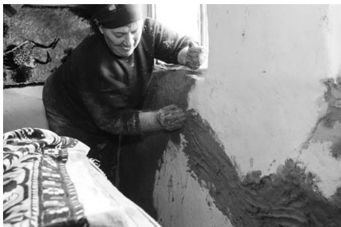
Obr. 3. Oprava hliněných stěn, Urmenis (Rumunsko), 2008. Foto Simona Šreková. Ze sbírky Muzea romské kultury v Brně.
