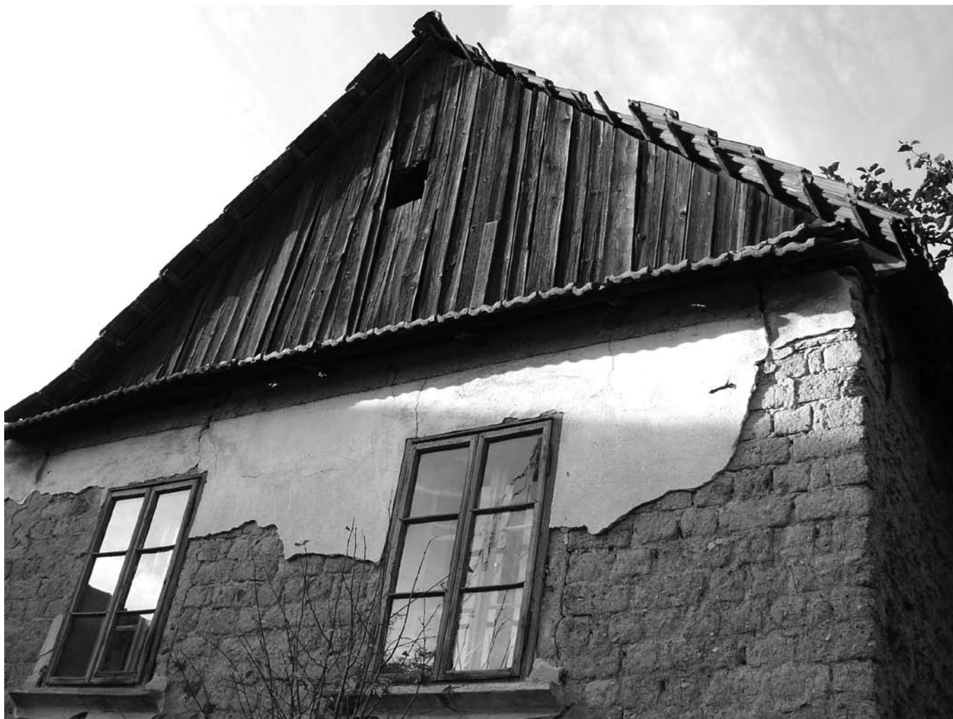
Obr. 6. Domkářská chalupa postavená z nepálených cihel. Přetrvávání hlíny jako stavebního materiálu u sociálně slabších vrstev vesnice ve 20. století. Kunčina Ves (okr. Blansko). Foto M. Válka 2004.
