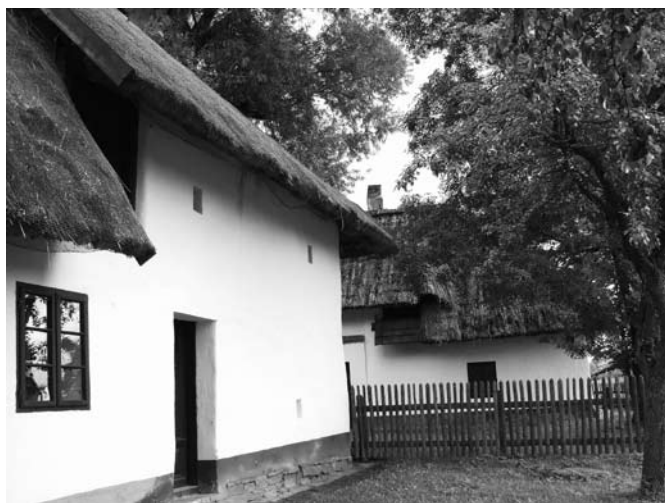
Obr. 4. Domkářská zástavba z přelomu 18. a 19. století na východní Hané. Chalupy s roubenou jízbou a horní komorou (dolní komora vyzděná) po stavební rekonstrukci pro muzejní účely. Rymice (okr. Kroměříž). Foto M. Válka 2011.
