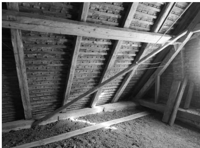
Vratěšín čp. 66, jednoduchý způsob zavětrování nůžkového krovu, 1892/93 d. Foto J. Bláha 2014.
