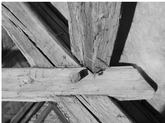
Šatov čp. 162, detail uložení mezilehlé vaznice na přesahující konec vodorovné rozpěry, 1810/11 d. Foto J. Bláha 2013.
