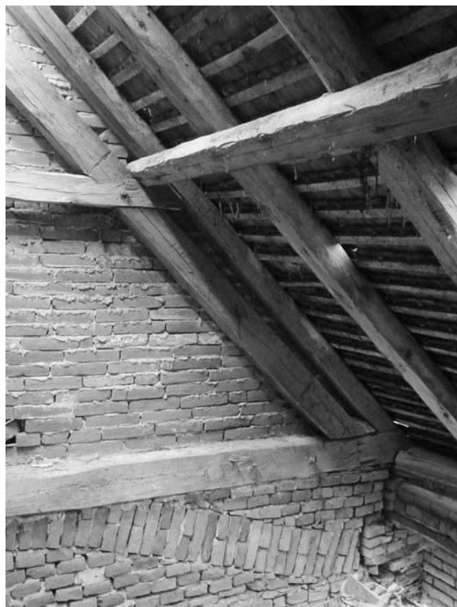
Onšov čp. 4, spodní část krovu s nůžkovou konstrukcí, 1864 d. Foto J. Bláha 2013.
