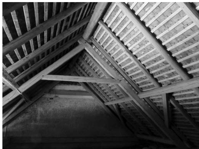
Štítary čp. 49, příklad podélného zavětrování nůžkového krovu pásky, 1905/06 d. Foto J. Bláha 2013.
