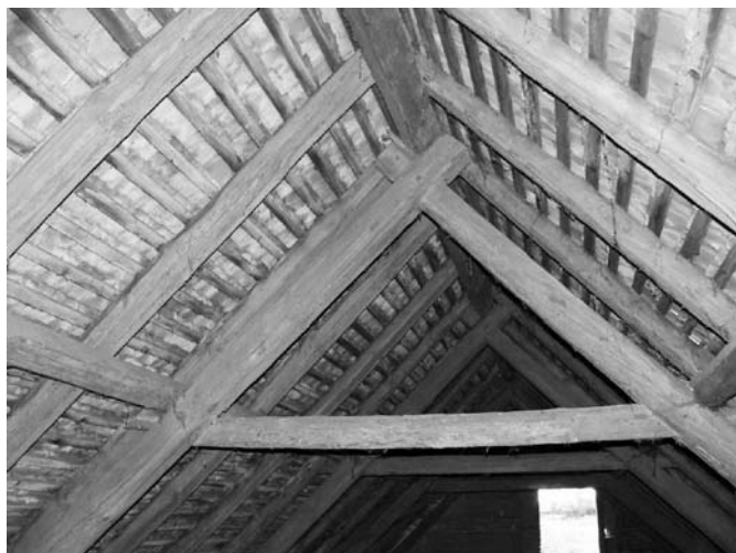
Onšov čp. 4, horní část krovu s nůžkovou konstrukcí, 1864 d. Foto A. Dunajová 2012.
