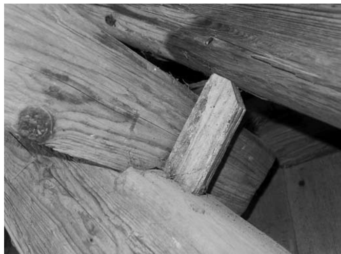
Vratěšín čp. 66, detail uložení mezilehlé vaznice pomocí mělkého kampe a zarážky z tvrdého dřeva, 1892/93 d. Foto J. Bláha 2014.
