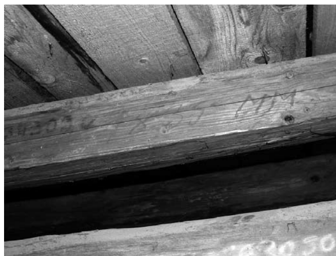
Štítary čp. 133, datace 1835 na krokvi plné vazby. Foto A. Dunajová 2014.
