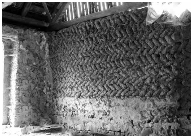
Obr. 2. Klasovitá vazba zdiva z hliněných válků. Pivín čp. 149 (stodola). Foto Martin Novotný 2011. Archiv NÚLK
