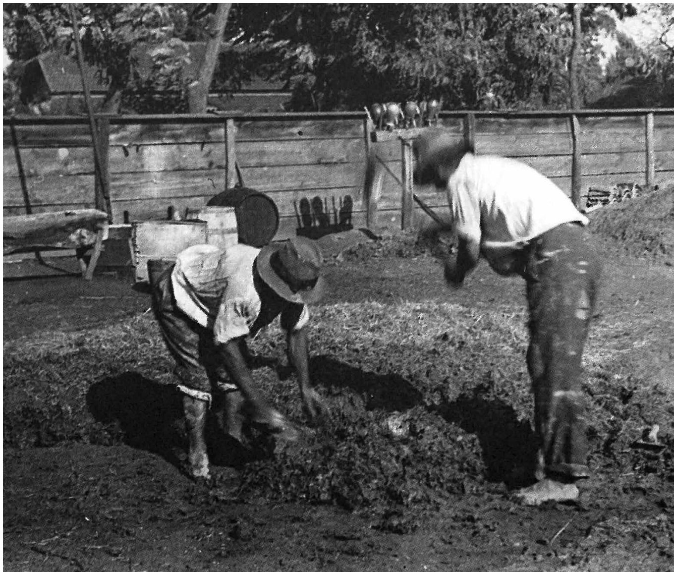
Obr. 5. Příprava hliněné omítky. Tiszaszőlős (Maďarsko), 1938. Dle Sabján – Buzás 2003: 118
