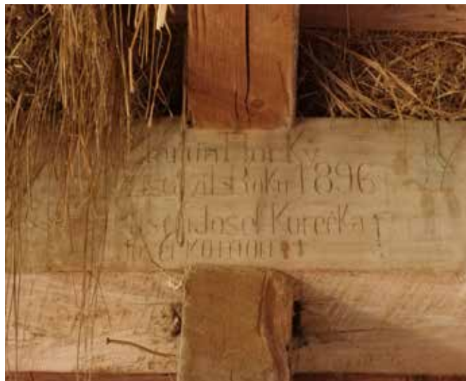
Obr. 4. Stropní trám stodoly z roku 1896 s údaji o vzniku stavby. Vnorovy, místní část Spinek. Foto Martin Novotný 2018. Archiv NÚLK
