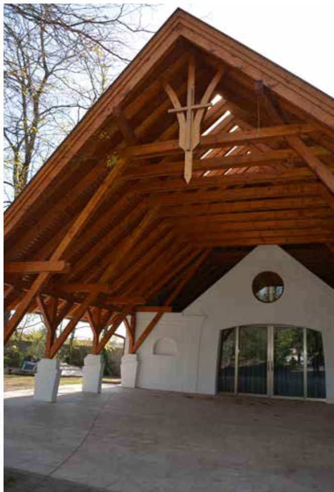
Prestavaný dom smútku v Malých Dvorníkoch dizajnovane nadväzujúci na tradičnú architektúru. Foto Zuzana Beňušková 2018
