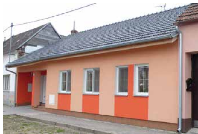
Nový dům postavený na místě demolované stavby. Uh. Ostroh, ul. Svobodova č. 30. Foto Helena Beránková 2015
