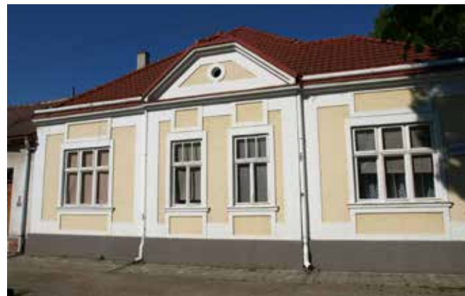
Současný stav domu. Uh. Ostroh, ul. Bartákova č. 9. Foto Helena Beránková 2016
