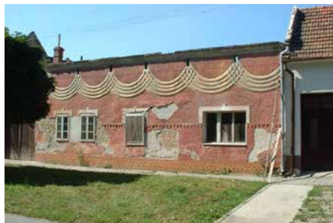
Postupná demolice. Foto Helena Beránková 2005
