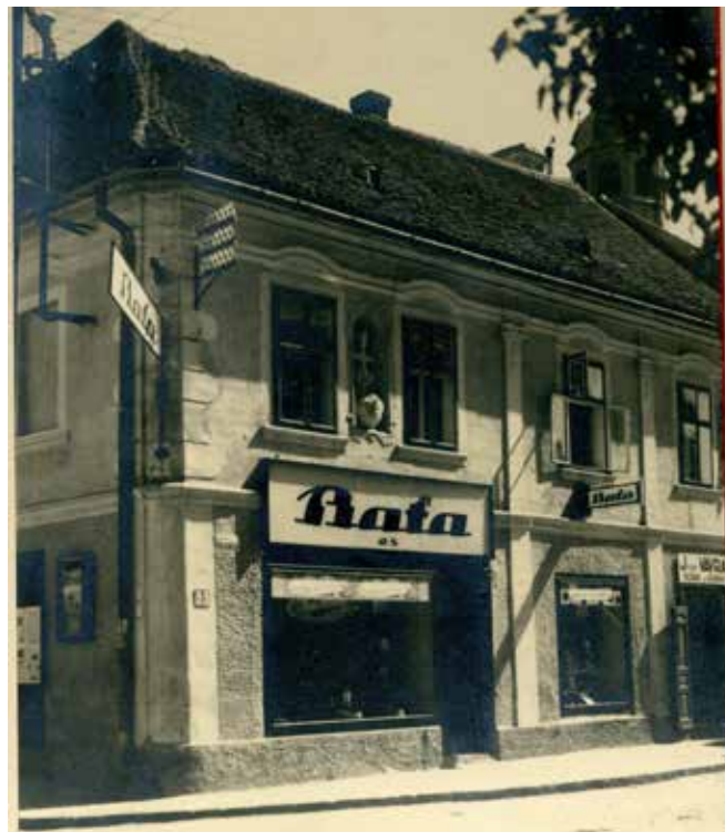
Patrový dům Antonie Foretové v historickém jádru Uh. Ostrohu po realizované adaptaci prodejních místností v přízemí. Foto Antonín Koukal, ca 1935. Soukromý archiv autorky
