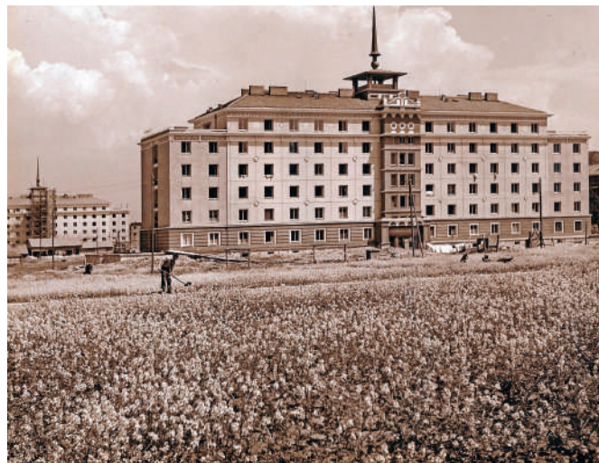
Budova jednej z dvoch slobodární, ktoré boli postavené v Novej Dubnici ako prvé domy. 50. roky 20. storočia. Dokumentácia Mestského úradu Nová Dubnica (MÚ ND)
