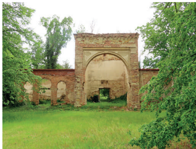
Obr. 5. Torzo obřadní síně na novém židovském hřbitově v Roudnici nad Labem (1890), zničené požárem v roce 1985 a následným nedostatkem údržby a vandalismem. Foto Zdeněk R. Nešpor 2024
